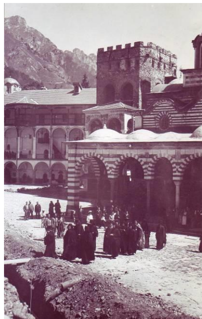
Прокопаване на дворната канализация в манастирското ядро 1932 г.
