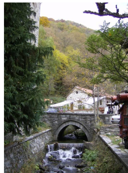
Корекция на р. Друшлявица при моста на главния път от север на манастира, средата на 50-те години (добър пример)
