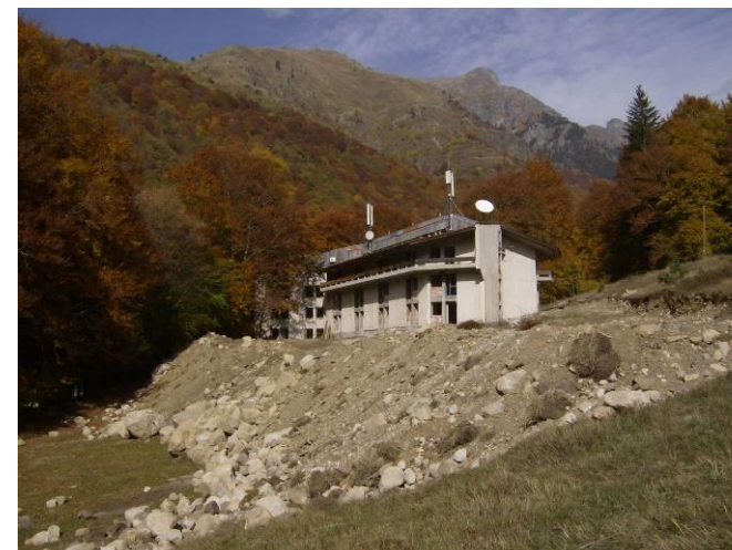
Изкопно-насипни строителни работи, с навлизане в охранныя зона на резерват „Риломанастирска гора”, октомври, 2008 г.
