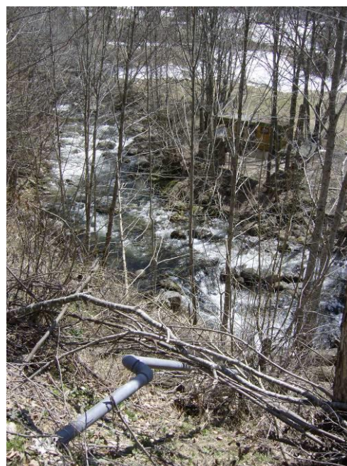
Водопроводно отклонение към имот 60.40 март, 2009 г.
