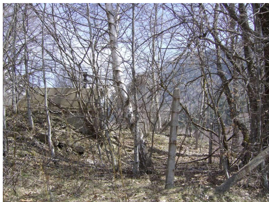
Каптаж югоизточно от Теодосиева постница, северно от пътя, март, 2009 г.
