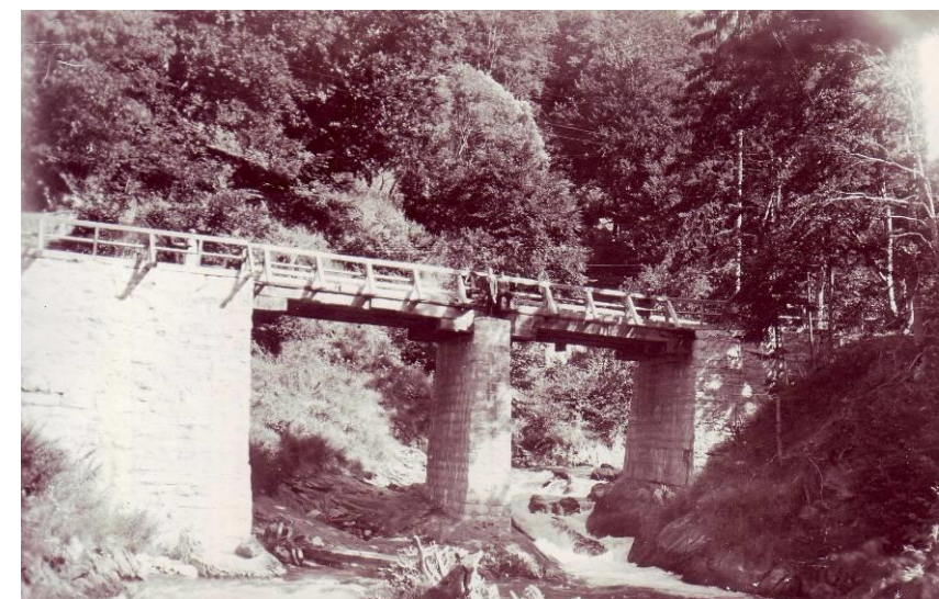
Каменният мост над р. Рилска, изграден за преминаване на ЖП линията от гарата до фурната, снимка от 1932 г., архив на Рилската Света обител
