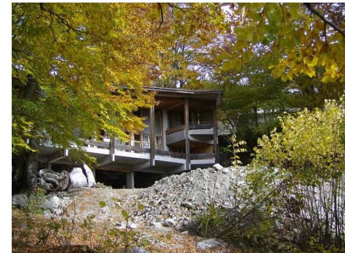
Нерегламентирано изхвърляне на строителни отпадъци, хотел „Рилец”, октомври, 2008 г.
